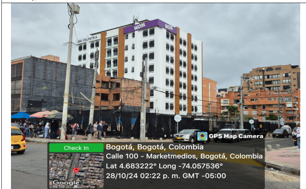
Fotografía No. 3 – Vista panorámica del lugar donde se encontraba instalado el elemento en la Av. Carrera 13 No. 95 – 08 (dirección de registro) y/o Calle 95 No. 23 – 20 (dirección catastral), orientación SUR – NORTE , donde se evidencia que fue desmontado.
